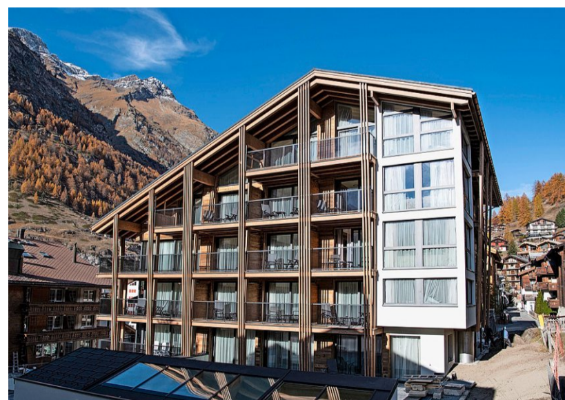
Kühne Holzfassade und deckenhohe Fenster: Das neue Altiana in Zermatt
